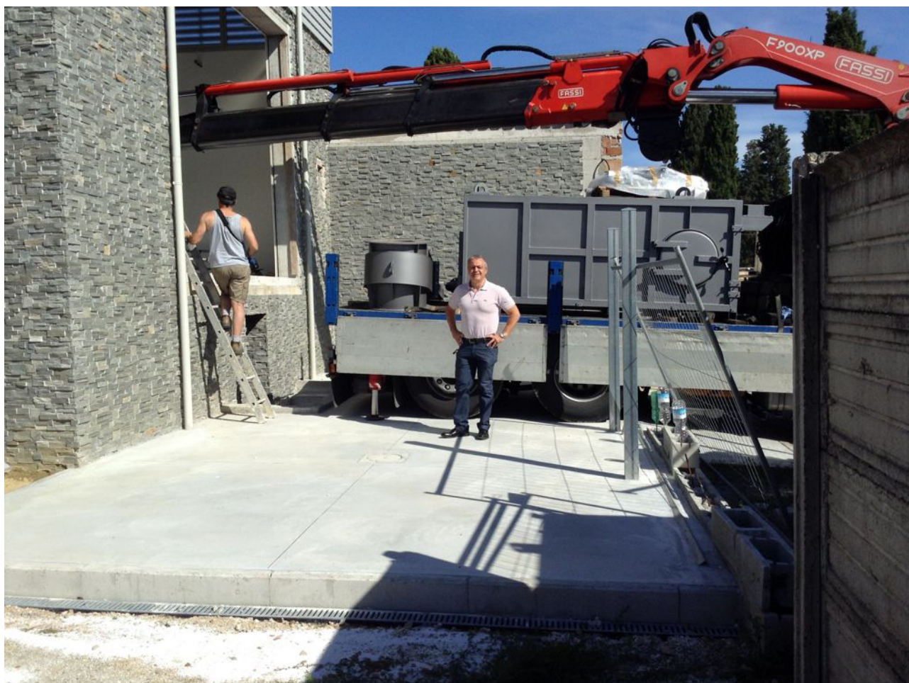
Il forno crematorio in fase di realizzazione
